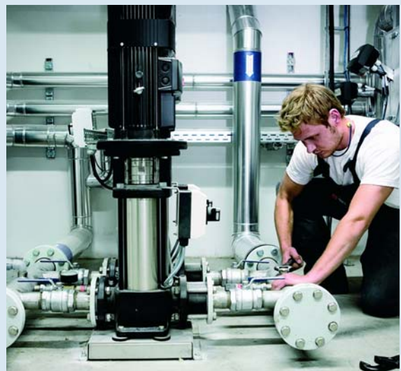
Монтаж станции Grundfos Hydro MPC на объекте
